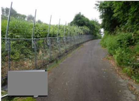
【施工事例 (秋田外環状道路 秋田北IC～昭和男鹿半島IC)】
